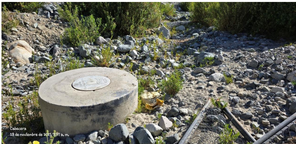
FIGURA N°03: LAS AGUAS PROVENIENTES DE LA GALERIA FILTRANTE SE ALMACENAN EN EL RESERVORIO CABECERA, LA CUAL ESTA EXPUESTA A LA TEMPORADA DE MAXIMAS AVENIDAS
